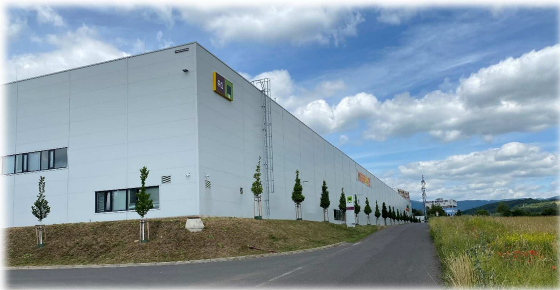
Nesprávné řešení – osázení obvodu stavby stromy
